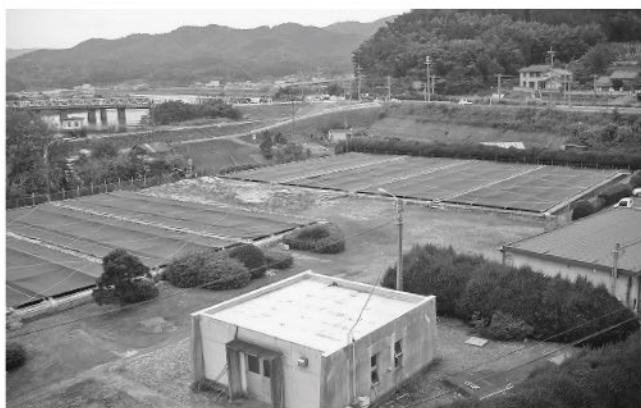
* 昭和8年から使用していた緩速ろ過池（左側）を膜ろ過施設（右側右奥の建物）に更新
