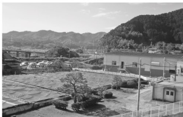
* 昭和8年から使用していた緩速ろ過池（左側）を膜ろ過施設（右側右奥の建物）に更新
