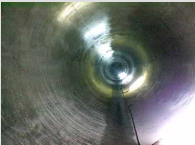
貯留施設の管内
